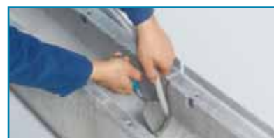
3. Einbringen der PE-Dichtschnur
