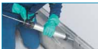
5. Einbringen des Fugendichtstoffes
