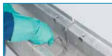
6. Glätten der Fugenoberfläche
